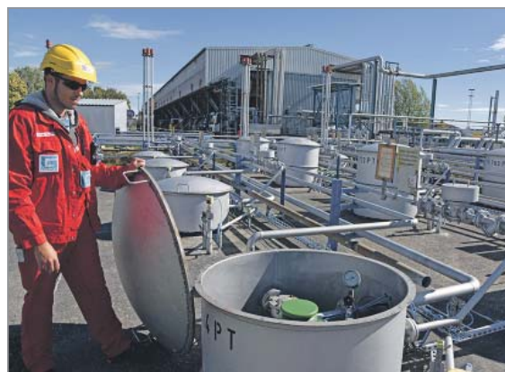
Die Additivtanks liegen unterhalb der überirdisch sichtbaren Gehäuse, in welchen sich Manometer und Pumpen befinden.
